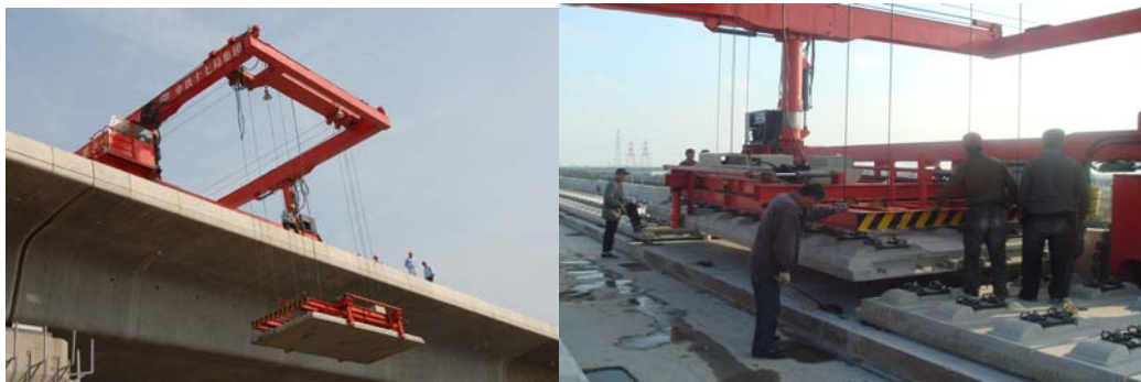
图4.1.2 龙门吊铺设轨道板
