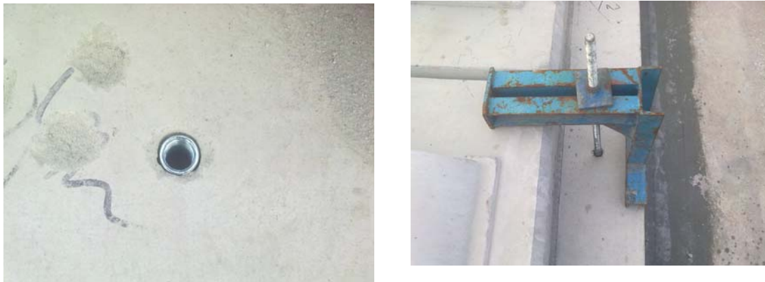
图4. 1. 1-3 轨道板定位锥位构造
