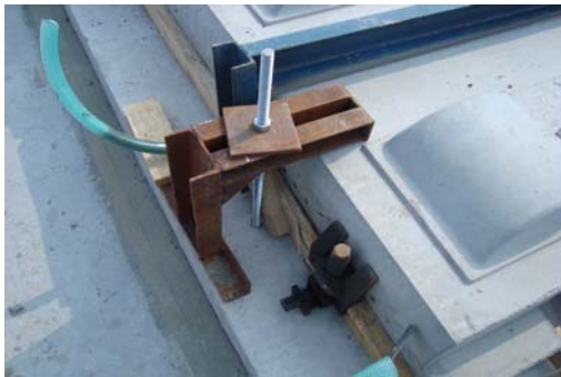
图 4 L 型扣压装置
