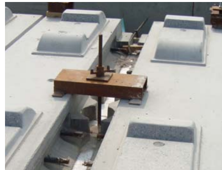
图 5 横向扣压装置
