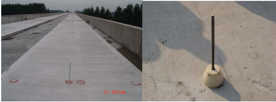
图4. 1. 1-2 轨道板GRP点及定位锥位布置
