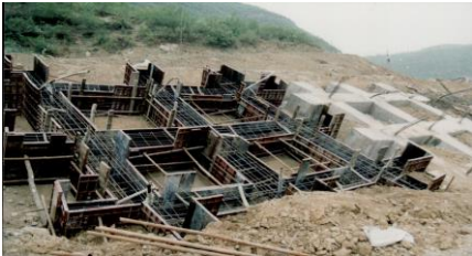
图 9—17 锚索框架支护
