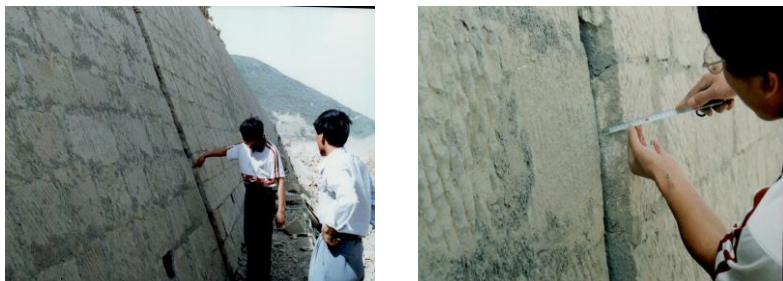
图 9—15 修好的挡墙因滑坡而错动
