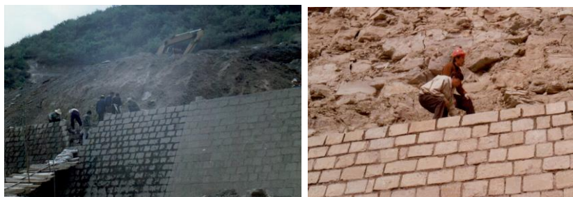
图 9—13 挡墙施工图
