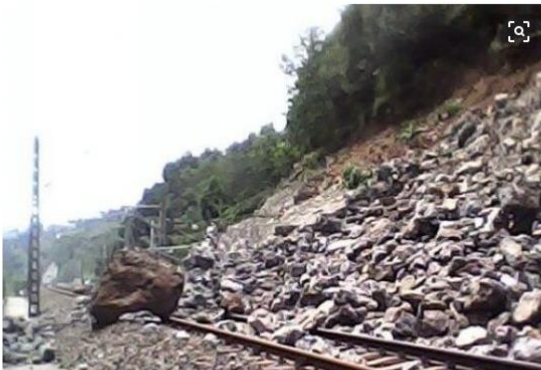
图 0-4 宝（鸡）成（都）铁路沿线崩塌
