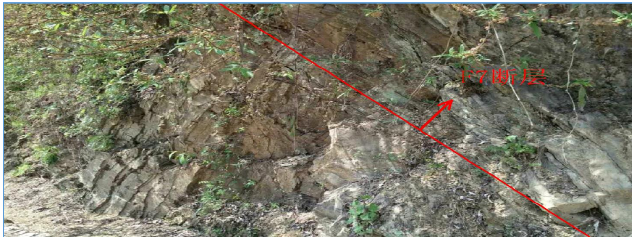
照片 15 F7 逆断层露头照片
